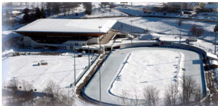
Baselga di Pinè 2017 - in costruzione -
